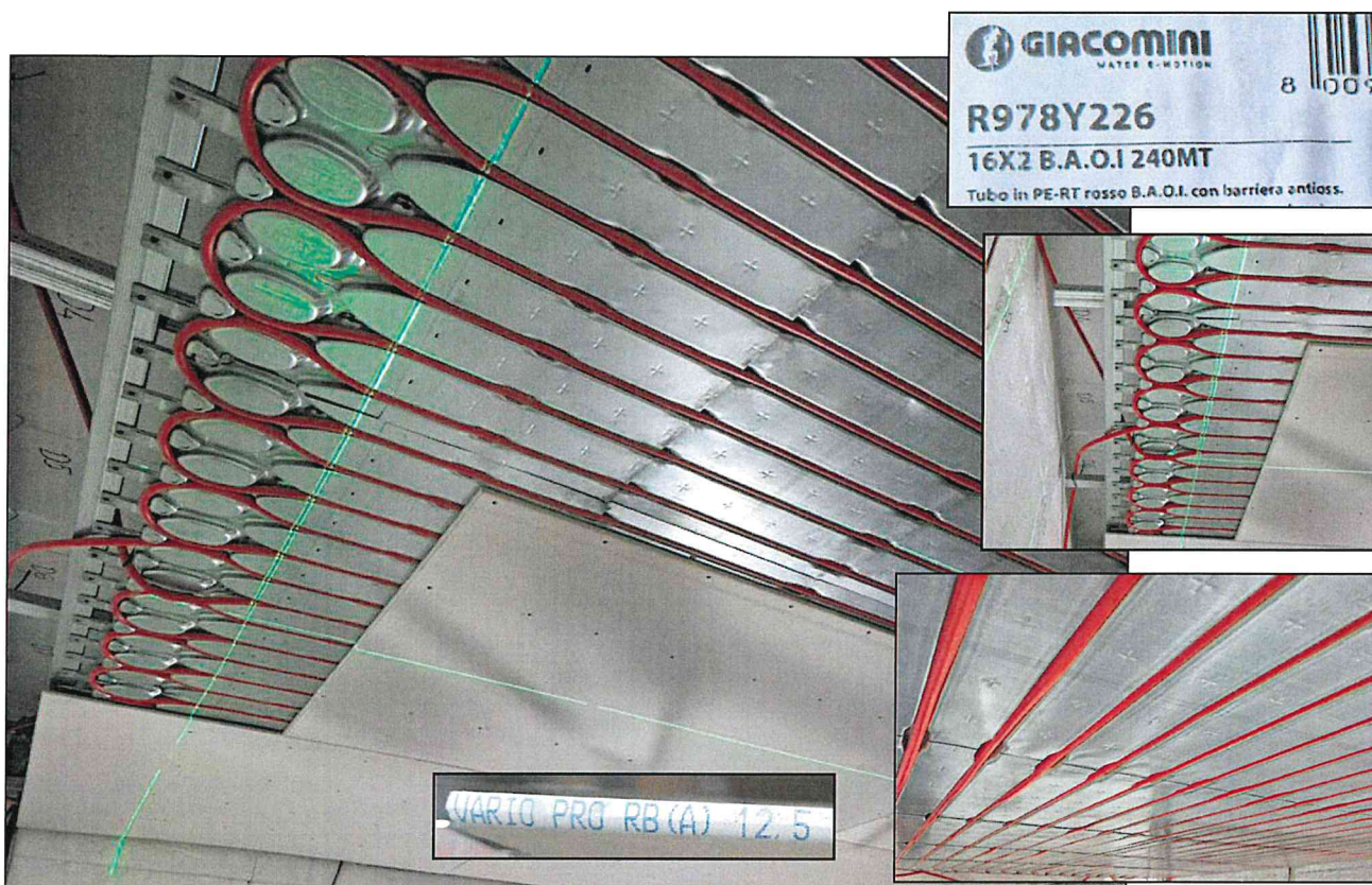
Geschlossene Kühldecke mit Rohren aus Kunststoff (PE-RT, 16 x 2,0mm), Onivo Plafino Ceiling, Onivo Sàrl, Beplankung Gipskarton (Fa. Rigips – Typ VARIO 12.5, ungelocht, 12,5mm, Wärmeleitfähigkeit \lambda : 0,25W/mK), Rohrabstand: 100mm
