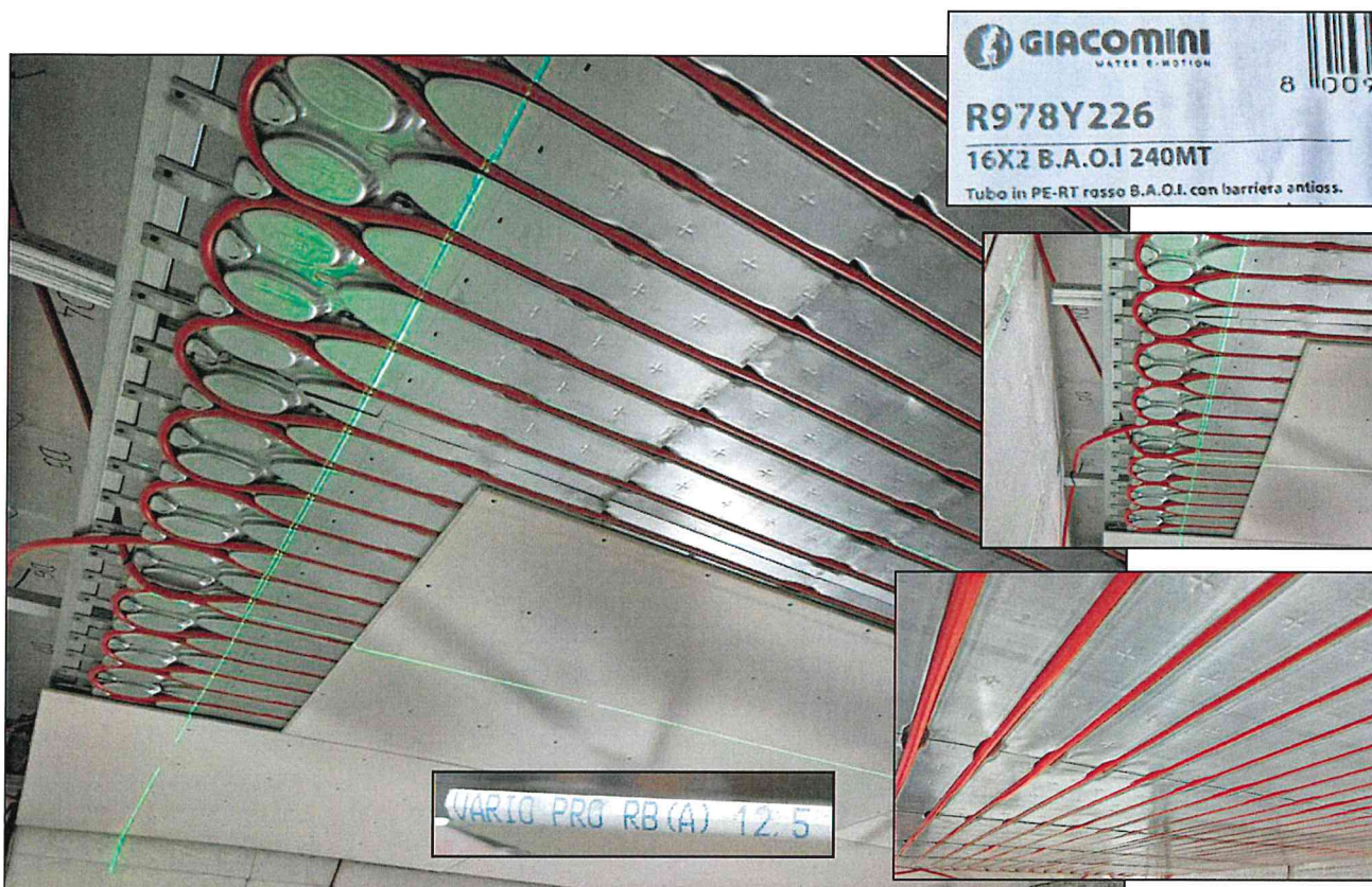
Geschlossene Decke (Heizung) mit Rohren aus Kunststoff (PE-RT, 16 x 2,0mm), Onivo Plafino Ceiling, Onivo Sàrl, Beplankung Gipskarton (Fa. Rigips – Typ VARIO 12.5, ungelocht, 12,5mm, Wärmeleitfähigkeit \lambda : 0,25W/mK), Rohrabstand: 100mm
